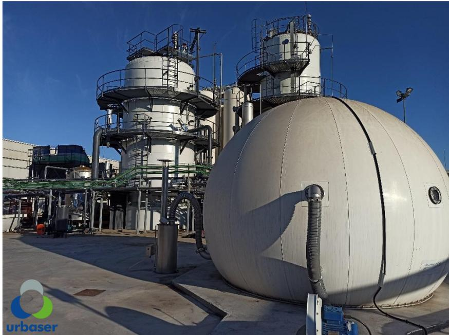
**Figura 2.** Vista trasera de la instalación. Gasómetro para la regulación de biogás y digestores.
