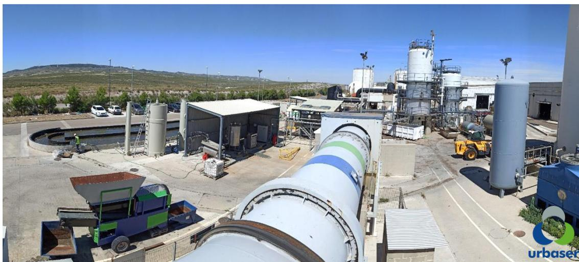
**Figura 4.** Biorrefinería Urbiofin instalada en el CiAM (Zaragoza). A la izquierda, la línea de upgrading de biogás y producción PHA. A la derecha, el sistema de digestión anaerobia en 2 fases.
